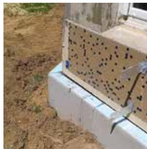
L'isolation des parties enterrées permet de réduire significativement les ponts thermiques du bâtiment et d'assurer la continuité esthétique en évitant le décroché lié au départ d'ITE à 15 cm du sol.
