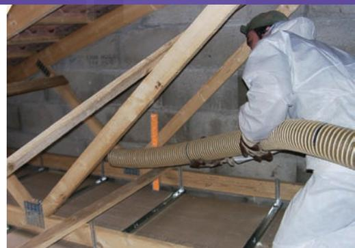
Complètement modulable en termes d'épaisseur, le soufflage de la laine de verre dans les combles est un travail qui permet de bénéficier des dispositifs fiscaux et qui peut apporter une modification radicale des caractéristiques thermiques du bâtiment. Naturellement, les améliorations dépendront du système constructif de l'habitation.
